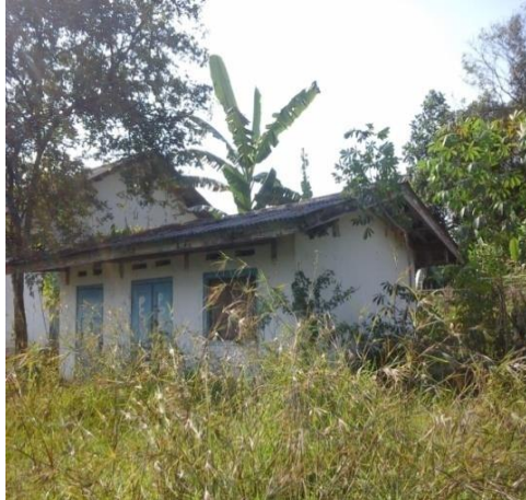
Kantor Pengairan yang tidak dipakai
